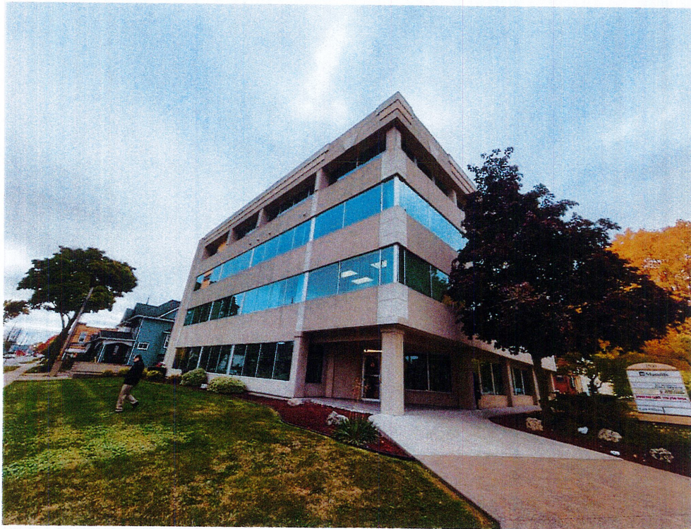
Exterior EIFS façade
